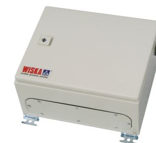
PSUH блок питания Размер: 360x380x220 Вес: 15 кг
